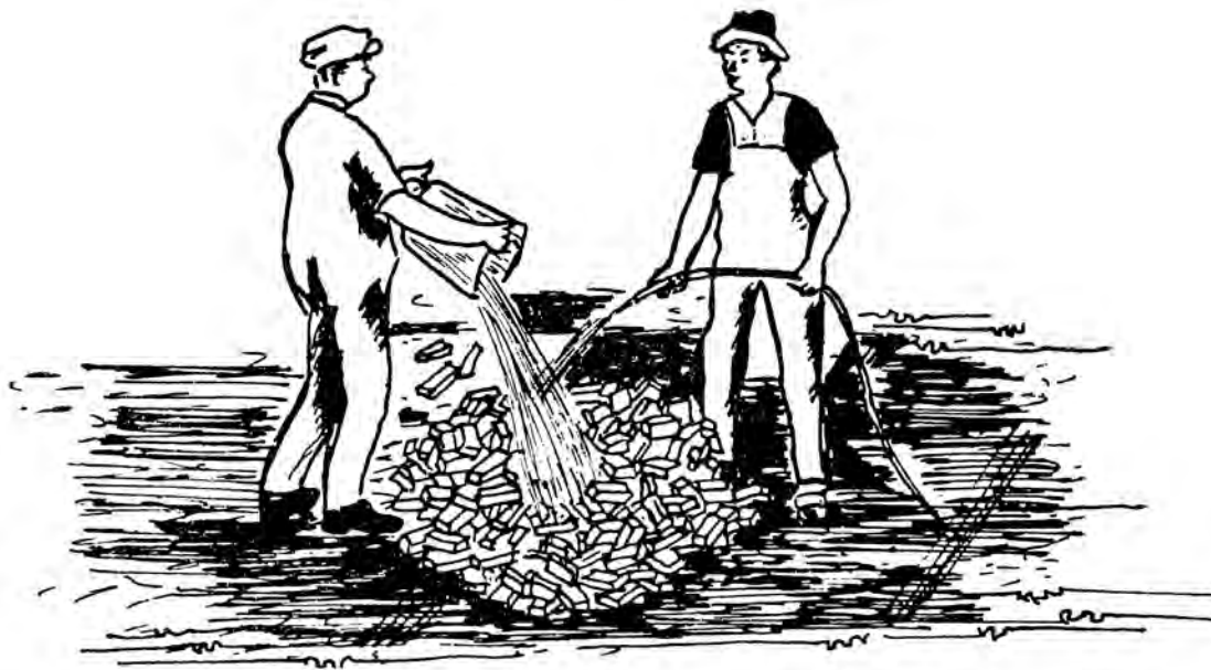
شکل ۳۷ ▲ زنجاب کردن آجر
