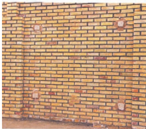
▲ شکل ۲۱ کرم‌بندی ابتدا و انتهای دیوار
