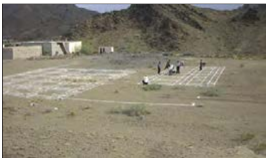
شکل ۸۳-۱ پیاده کردن نقشه روی زمین
