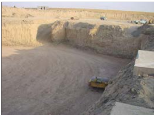
شکل ۸۴-۱ زمین گودبرداری شده
