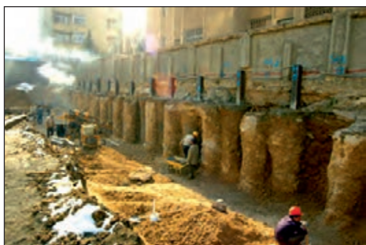
شکل ۸۸-۱ مهاربندی با پشت بند خاکی ستونی
