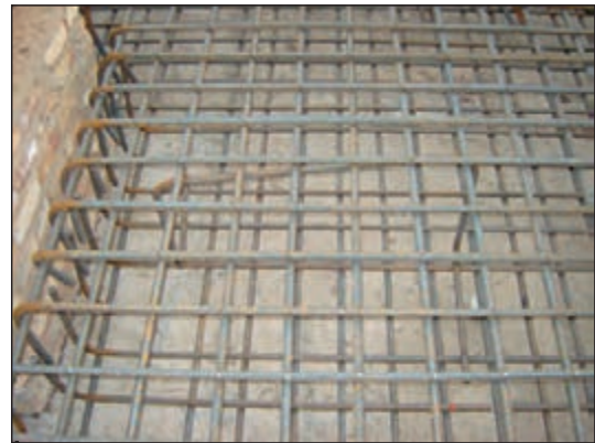
شکل ۱۴۷-۲ پی نواری و آرماتورگذاری آن
