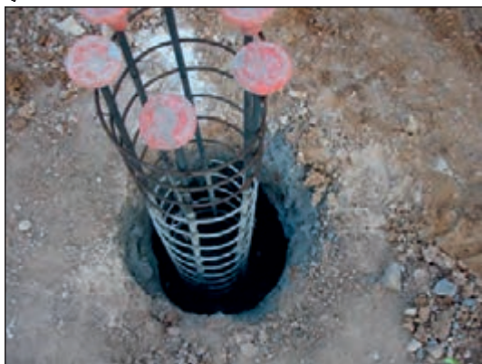
شکل ۱-۷۳ پی چاهی در حال اجرا
