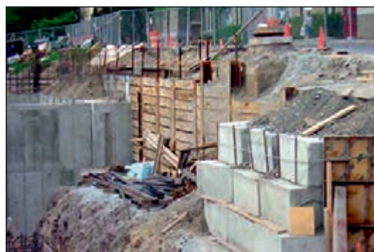
شکل ۹۱-۱ مهاربندی با دیوار مانع چوبی
