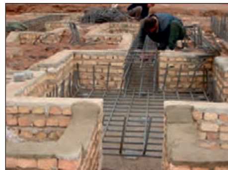
شکل ۱-۸۲ قالب‌بندی آجری در اطراف پی
