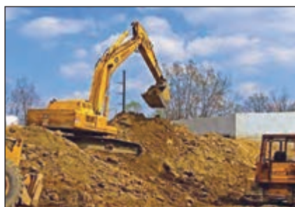
شکل ۱-۱۳- کندن زمین با وسایل مکانیکی
