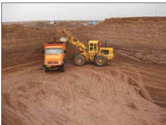
شکل ۸۵-۱ گودبرداری با لودر در زمین نامحدود
