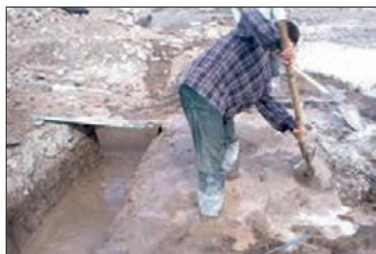
شکل ۱-۳۱ اجرای شفته آهک در فونداسیون
