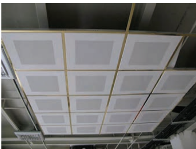
◀ شکل ۱-۶۰- سقف کاذب تایل آلومینیوم با شبکه فلزی
