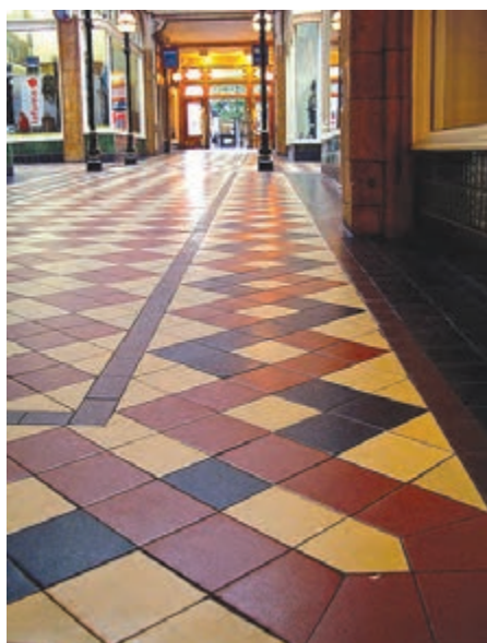
▲ شکل ۱-۷ کف‌سازی در داخل ساختمان
