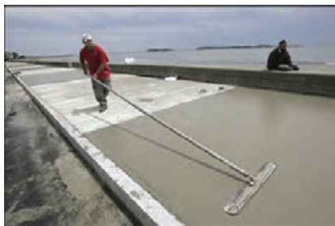
❖ شکل ۳-۵۵ رویه نهایی معابر با بتن درجا
