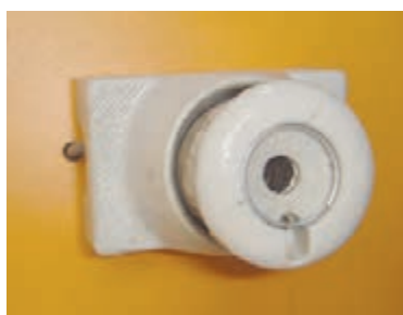
شکل ۱۳۴-۲ انواع فیوز
