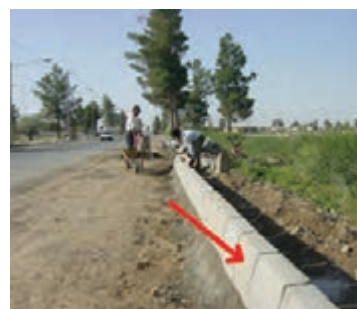
▲ شکل ۳-۳۱ جدول مانع عبور با شیب داخلی
