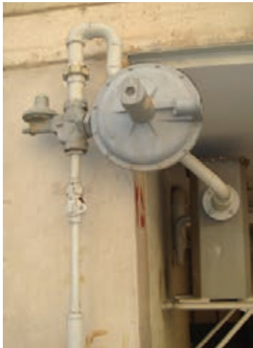
▲ شکل ۹۳-۲ علمک و رگولاتور روی آن
